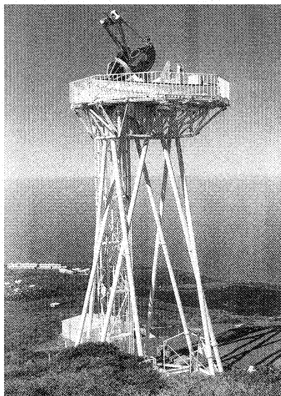
Figuur 3: De DOT in werking. Let op de rubberen dempers halverwege iedere torendriehoek die er voor zorgen dat de staven op elkaar dempen bij het eventueel aanslaan in de wind.
